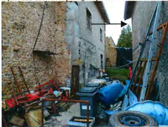
façade sud-ouest avec passage séparatif entre les deux maisons
