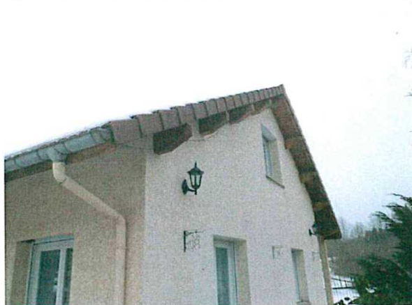
Vue de l'avancée de toit en ouest
