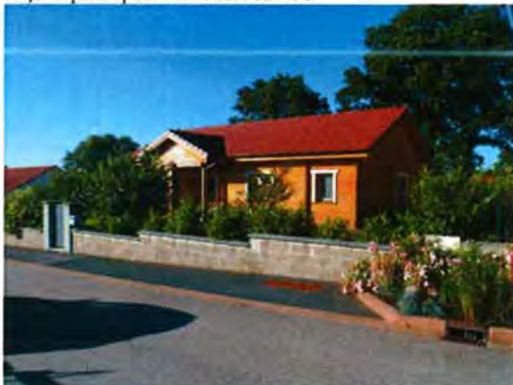
Façade principale sud-ouest sur rue
